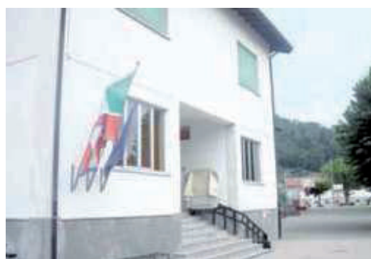
Il porticato delle scuole modificato
