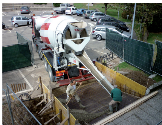
Lavori di rifacimento scala di ingresso del Comune resi necessari viste le condizioni in cui versava.
