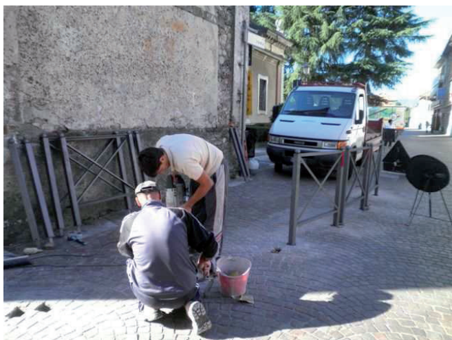
Lavori in Piazza Unità d'Italia
