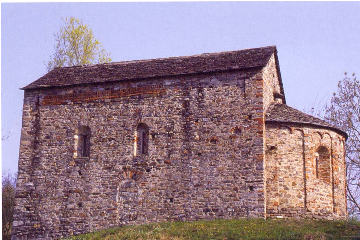
Il prospetto verso valle
