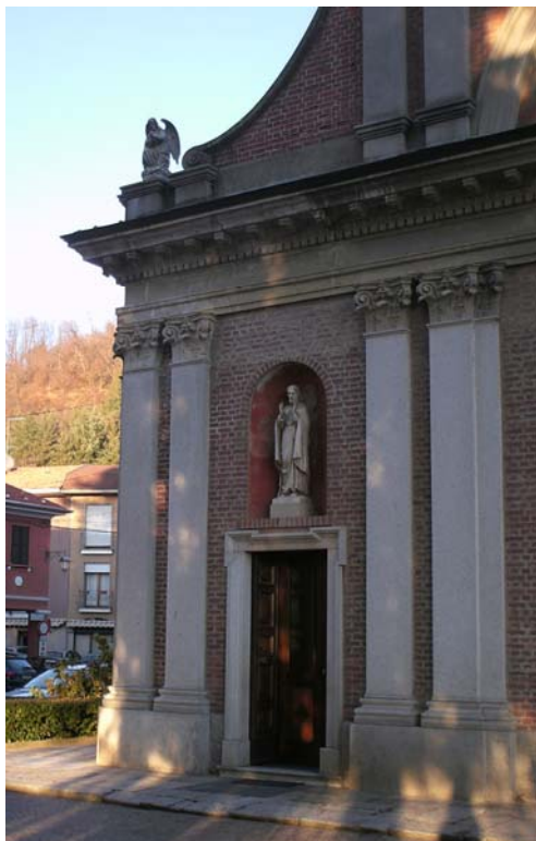
particolare della facciata
