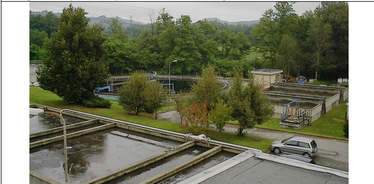
Immagine dell'impianto di depurazione del Comune di Briga Novarese
